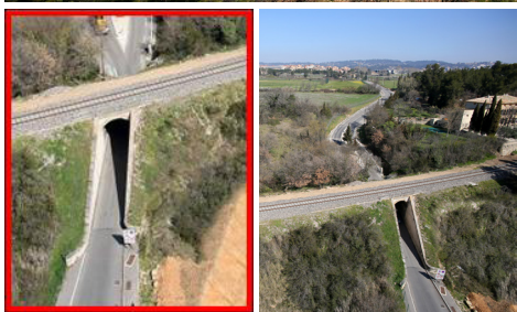
LE TUNNEL FERROVIAIRE
